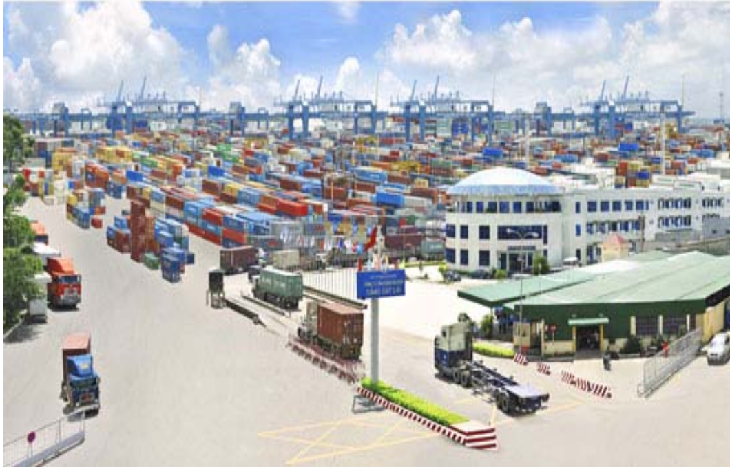
Hình 2.7: Cơ sở hạ tầng tại Tân Cảng Cát Lái.
